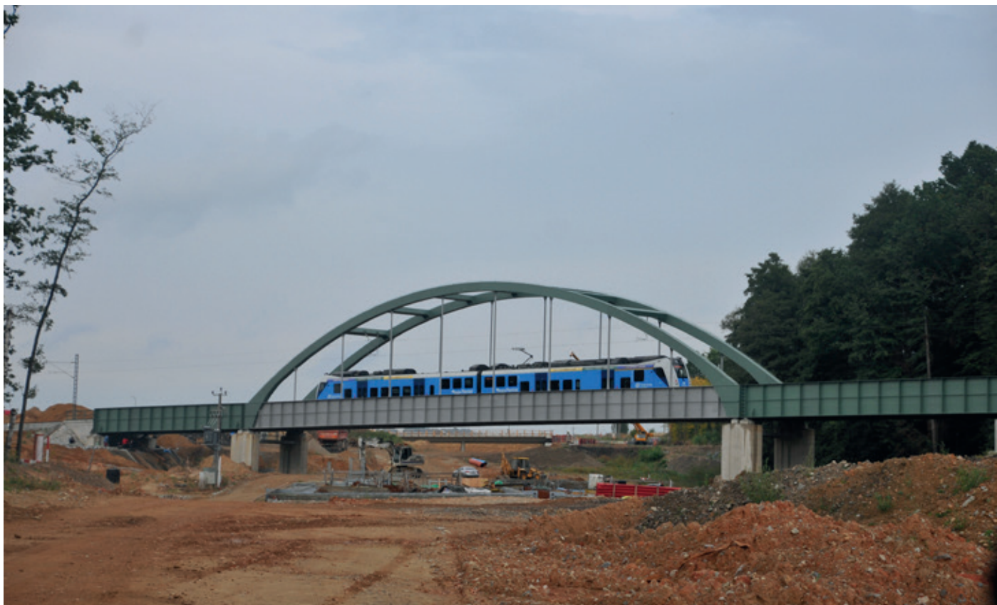
^ Železniční most přes dálnici D3
