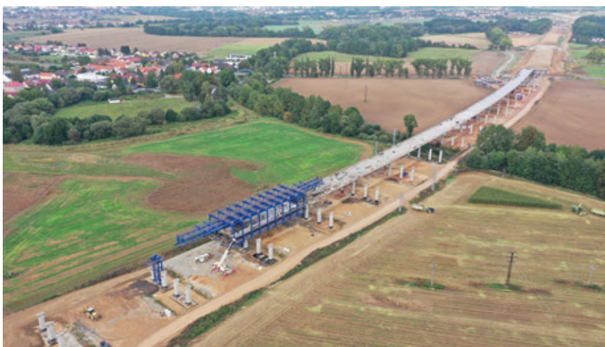
^ Most přes údolí Plavnice – výsuv ve zvýšené pozici
