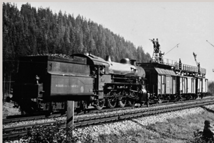
Lokomotiva řady 455.1 s pracovním vlakem při montáži trakčního vedení na Slovensku v období první pětiletky. Archiv EŽ Praha
