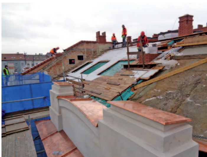
Práce na střeše budovy A.
