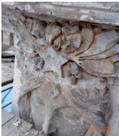
Očišťování stávající štukové výzdoby fasády.
