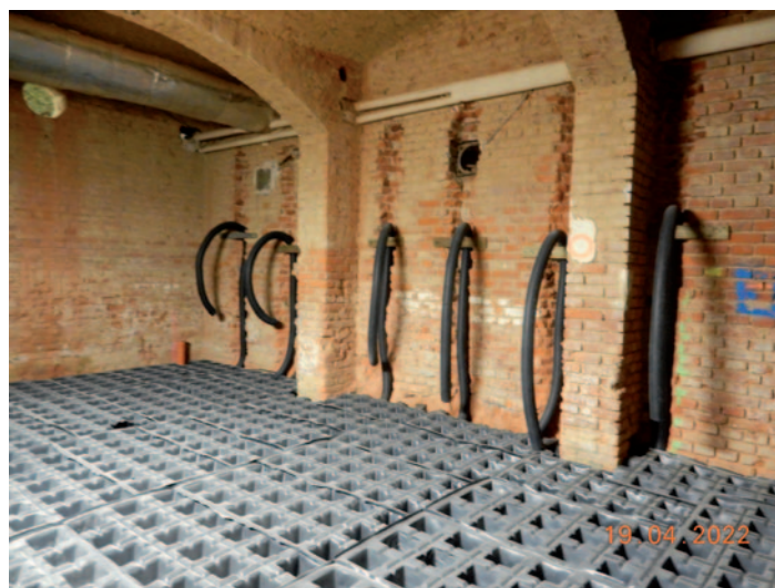
Provětrávané podlahy v suterénu budovy A.
