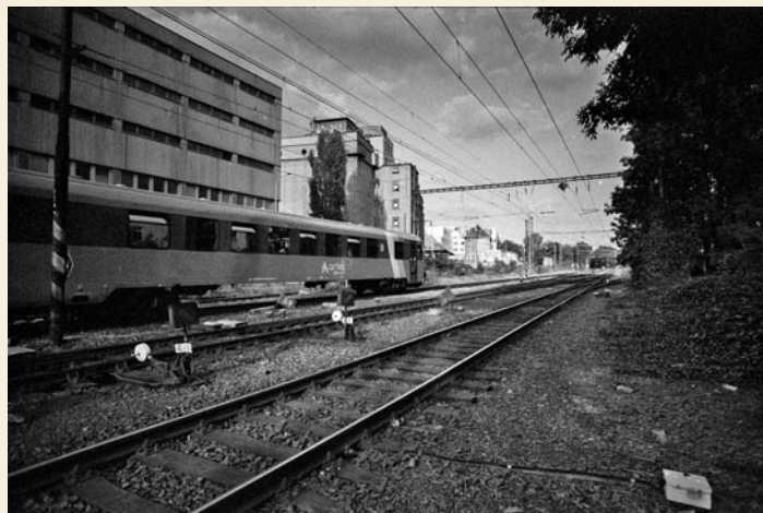
Odbočka vlečky z roku 1912 do ještě stojících Odkolkových pekáren. Na pozadí vpravo pak bývalá původní vlečka do Vysočanských závodů ČKD.
