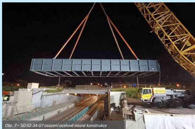
Obr. 7 – SO 02-34-07 osazení ocelové nosné konstrukce
