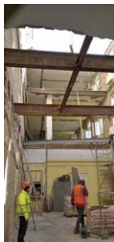
Osazování ocelového stropního nosníku do vysekaných kapes. Pohled vzhůru po odstranění střešní a stropních konstrukcí.
