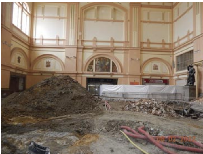
Bourání podlahy v hlavní suterénní hale.
