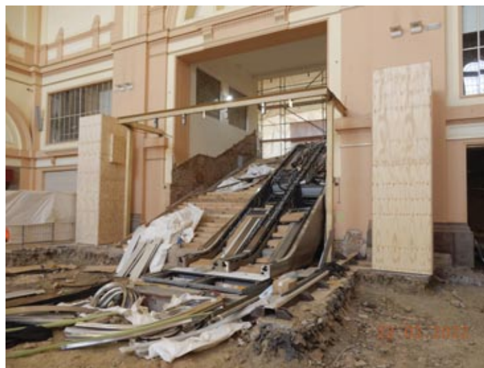
Dokončování montáže eskalátorů; sochy hutníka a železničáře opláštěny proti poškození.
