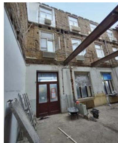
Osazování ocelového stropního nosníku do vysekaných kapes. Pohled vzhůru po odstranění střešní a stropních konstrukcí.
