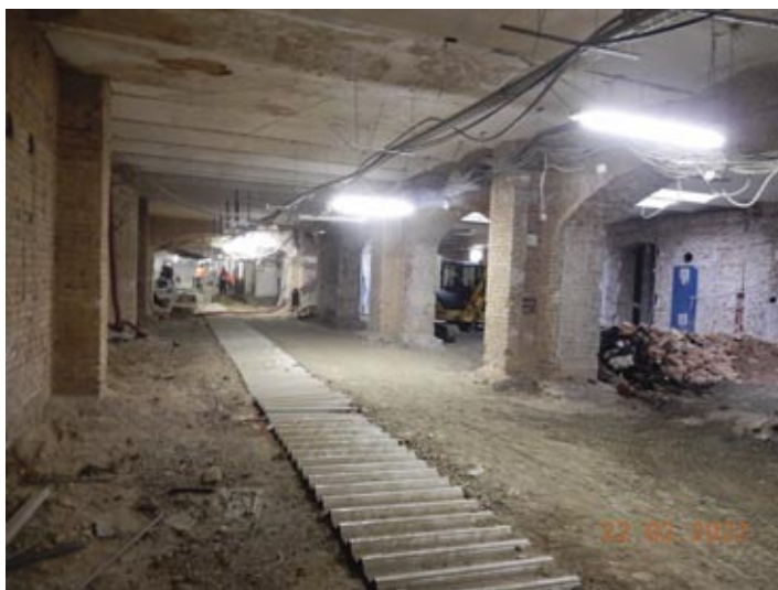
Střední část zavazadlového tunelu, pod trapézovým plechem se nachází ponechávaný kabelový kanál.
