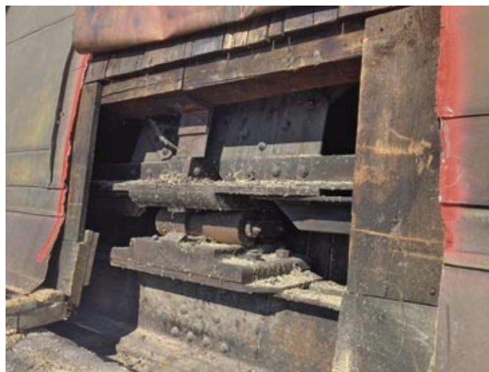
Sonda do kupole v místě uložení ocelové konstrukce na válcová ložiska.
