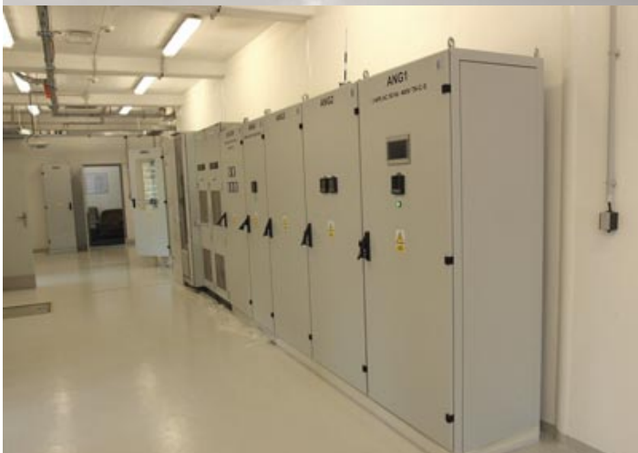
TNS Světec: hala technologie 22 kV a 3 kV a hala technologie vlastní spotřeby.
