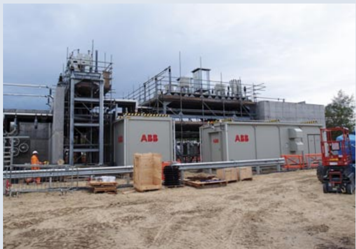
Kontejnery s měničovou technologií a řídicí technikou.
