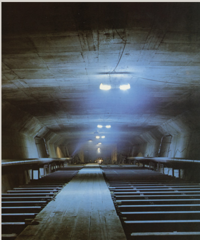
Tubus Nuselského mostu.
