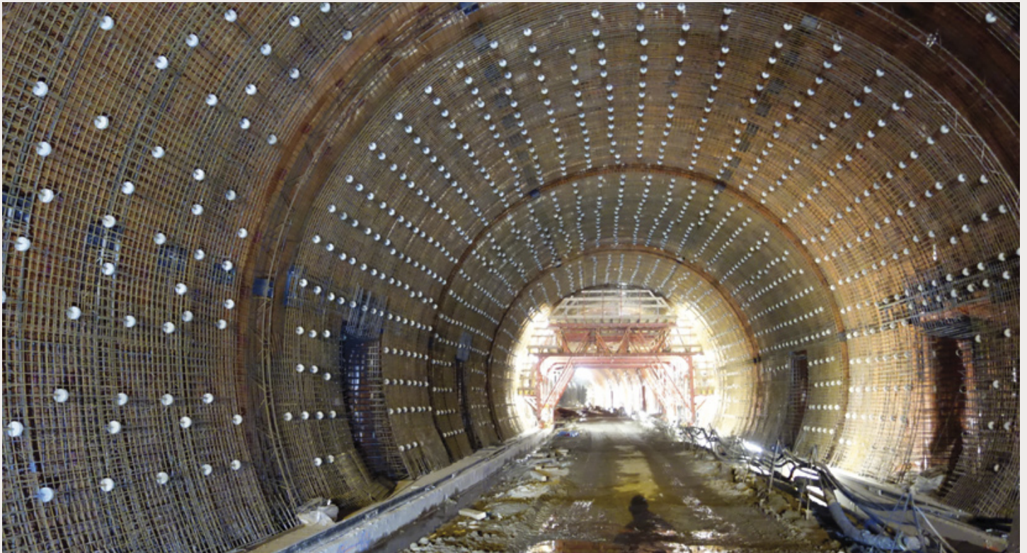
Armování definitivního ostění a ražba tunelu Mezno (stavba Modernizace trati Sudoměřice–Votice)
