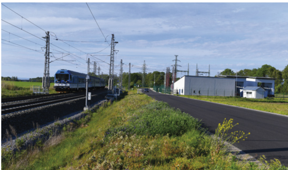
Pro budoucí nároky na přestavbu trakční soustavy byla postavena nová trafostanice.
