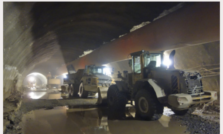
Armování definitivního ostění a ražba tunelu Mezno (stavba Modernizace trati Sudoměřice–Votice)
